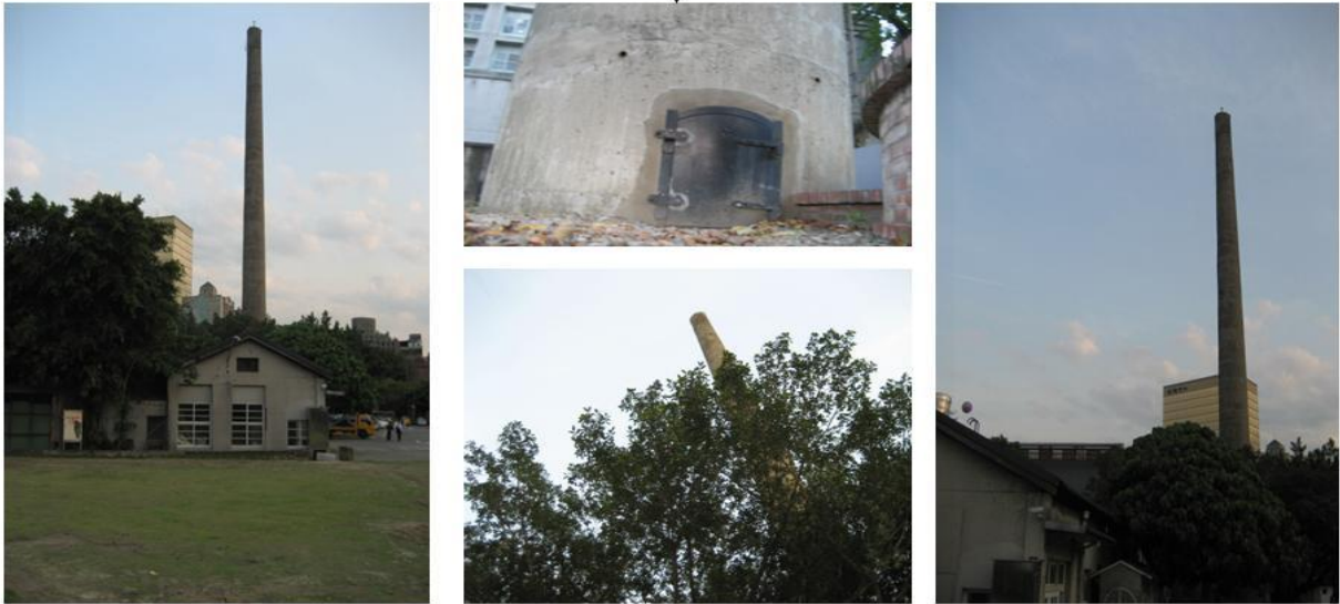
煙囪底部的爐子
