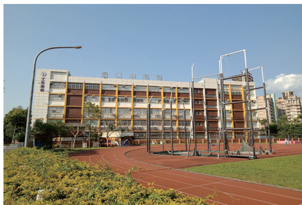
105 年力行樓完成整修
