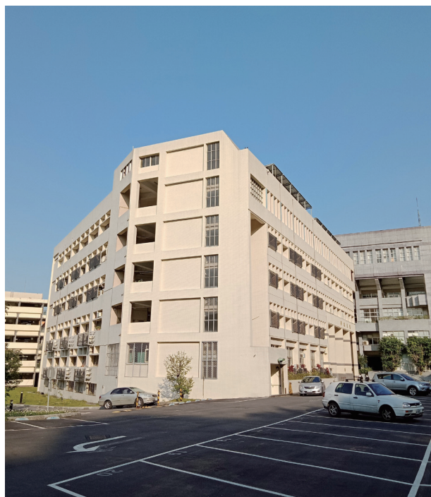
104 年行政大樓整修後
