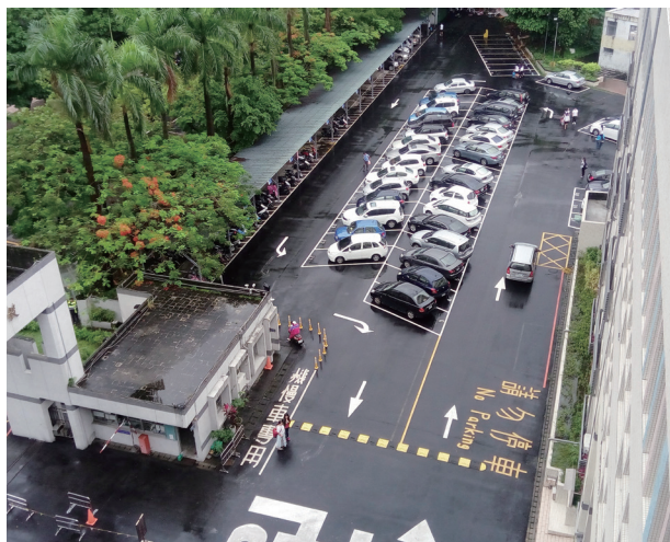
停車場整修完成後
