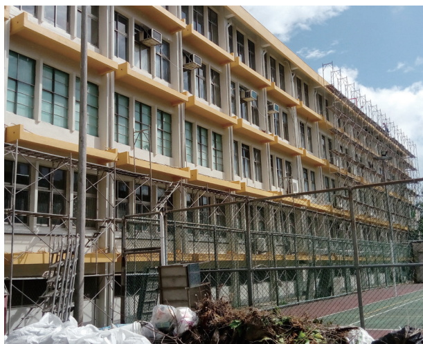
和平樓外牆整修
