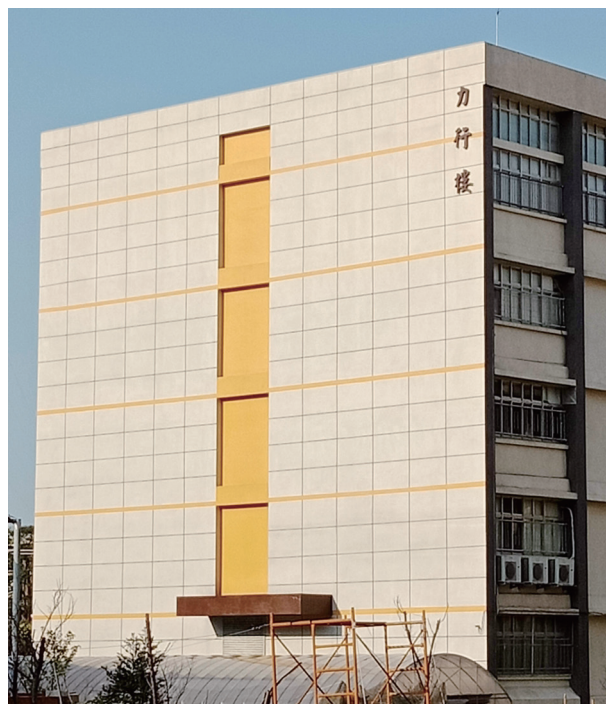
力行樓整修後
