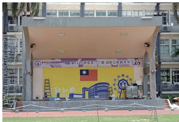
司令台防水整修
