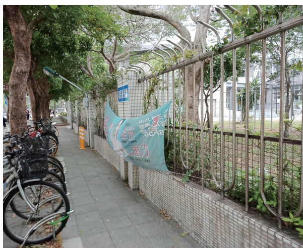
校園圍牆整修前
