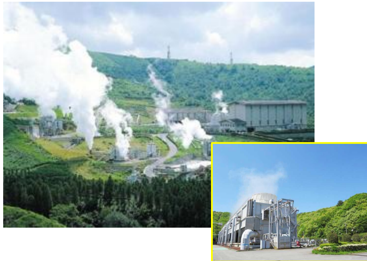
八丁原地熱發電所（九重町）
