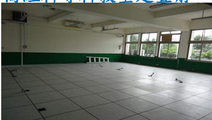
高架地板與線路完成
